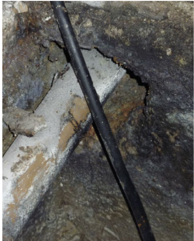
Schimmelbefall im feuchten Keller
