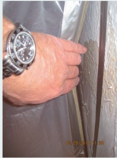
Abb. 2 und 3: Die Abschottung hält nicht; Klebebänder hatten sich abgelöst.
