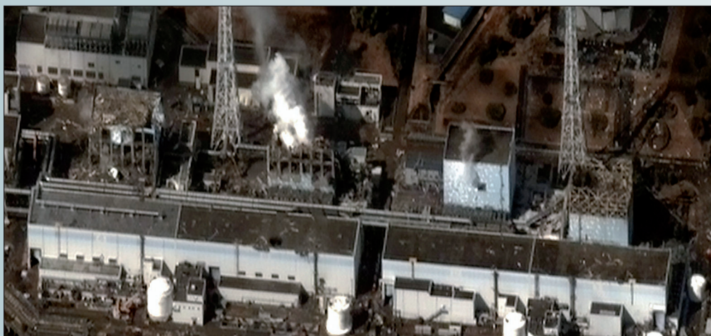
Die Reaktorblöcke 1 bis 4 des Atomkraftwerks Fukushima Dai-ichi (von rechts nach links) nach mehreren Explosionen und Bränden. Satellitenfoto vom 16. März 2011.
